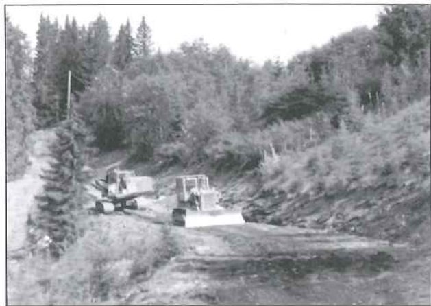
Arbeidet med nyvegen til Blommen i 1977.
