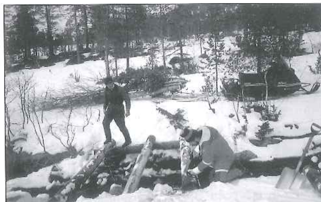
Mange år med regn og lite snø. Jarle Aurstad fra Leksdal IL og Per Olav Helden bygger bru.
